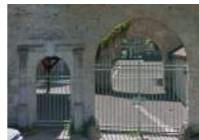
Arches médiévales Promenade des Écoles
