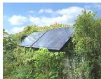
Les capteurs thermiques sont adossés à un mur du jardin. Cette solution demande une surveillance de la croissance de la végétation pour éviter toute ombre portée. Vigny (Val d'Oise) © PNR du Vauxin français
