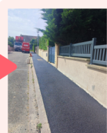
RUE DE L'AULNETTE Rénovation des trottoirs
