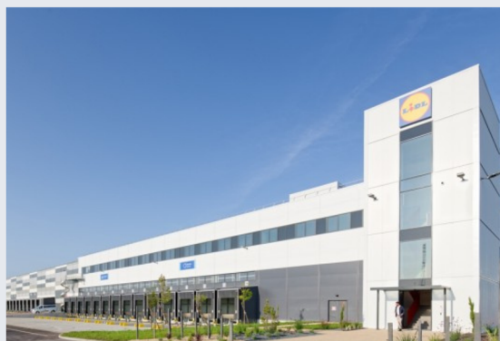
PLATEFORME LIDL À ABLIS
