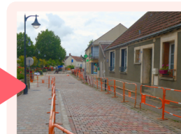
PLACE JEAN-CLAUDE DAUVILLIERS Réfection de la chaussée
