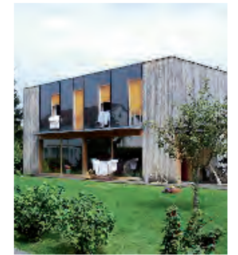
Les capteurs posés verticalement participent pleinement de la composition de la façade. Maison individuelle à Wolfurt (Vorarlberg, Autriche) © CAUE 78
