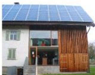
Un ensemble de capteurs recouvre toute la surface du toit, comme une nouvelle couverture.
